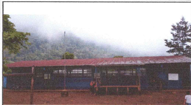
Foto1: cambio de cubierta de lamina y cambio de pintura
