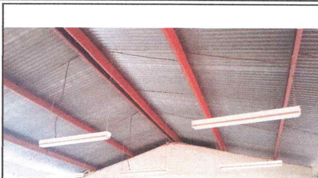
Foto 2: mantenimiento de costaneras (lijado y pintado)
