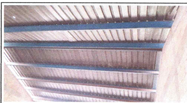
Foto 4: mantenimiento de costaneras (lijado y pintado)
