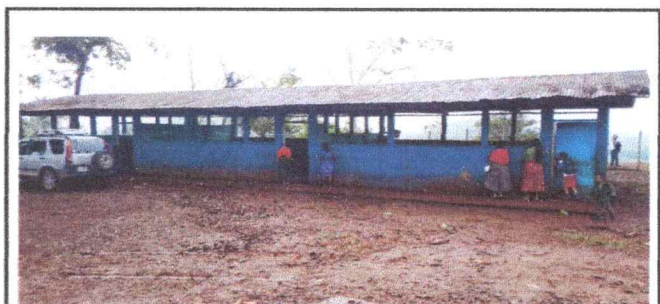
Foto 5: cambio de cubierta de lamina y cambio de pintura
