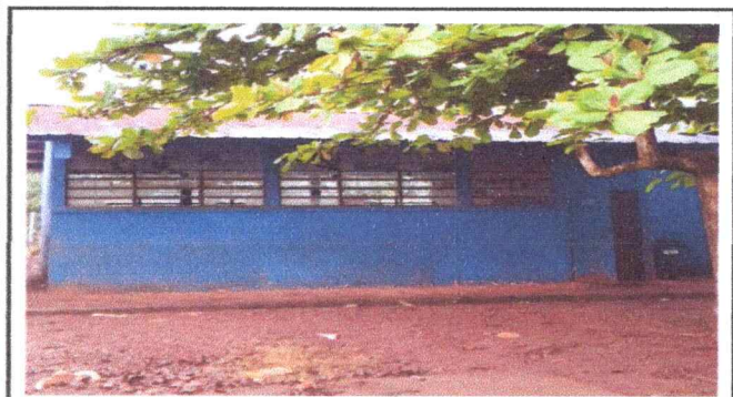
Foto 3: cambio de cubierta de lamina y cambio de pintura
